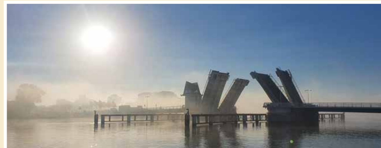
v Schleibrücke Kappeln
